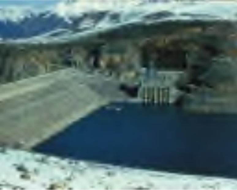
Чарвакская ГЭС (слева верхний бьеф с водохранилищем - 2006 млн.м<sup>3</sup>, справа нижний бьеф, с видом на плотину, высота 168 м., и станционное здание)
